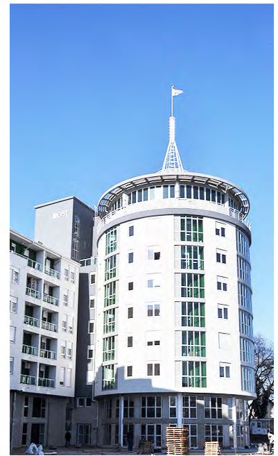
Stambeno-poslovni objekat Most II Ruma
